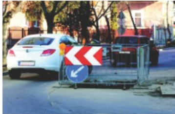
Csatorna-felújítás a Szabolcs utcában
